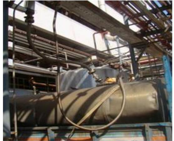
槽罐车进料排空平衡装
