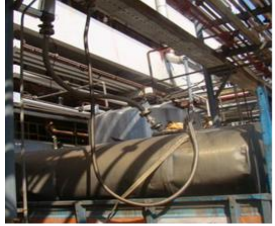
槽罐车进料排空平衡装置
