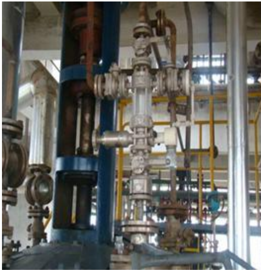
合成釜自动取样器
