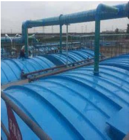
污水收集池加盖
